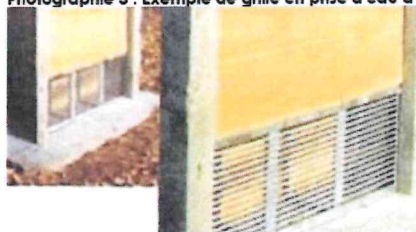
Photographie 3 : Exemple de grille en prise d'eau d'un moine
