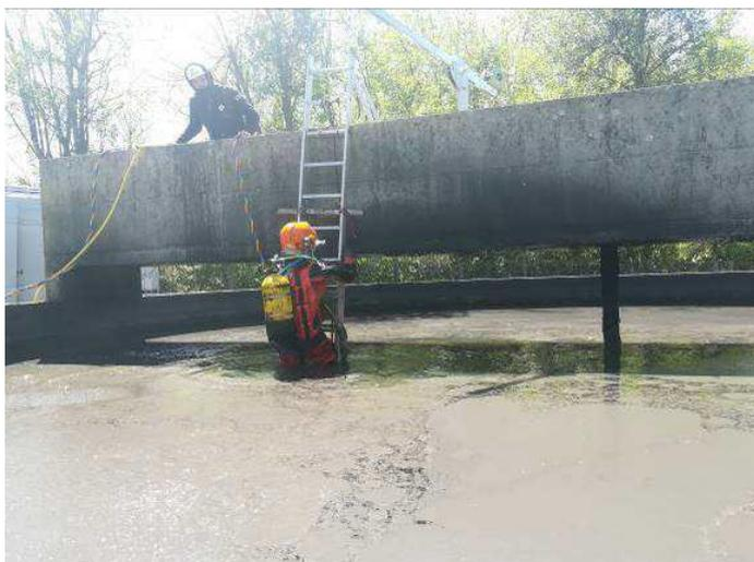
Installation de l'agitateur et des barres de guidage associées
