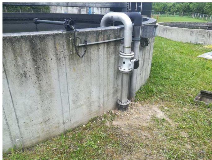
Remplacement de la conduite d'alimentation des eaux brutes et installation du débitmètre électromagnétique
