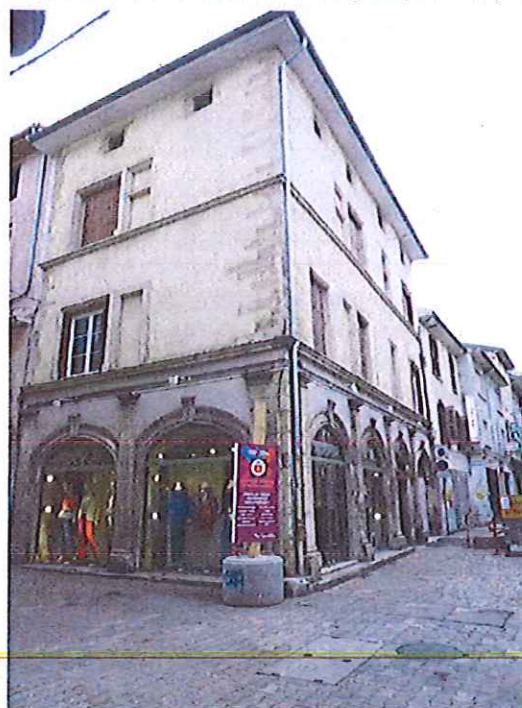
Rue de la Liberté avec alignement bâti continu en front de rue Ancienne chapelle de 1503 avec détail du portail Immeuble renaissance
