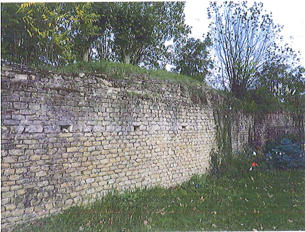
Mur de terrasse antique
