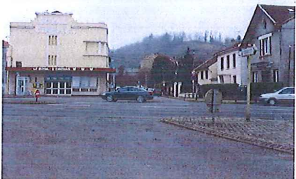
Avenue des Alpes – Royal Cinéma, construction XXe siècle de l'architecte berjallien Albert Ribiollet.
