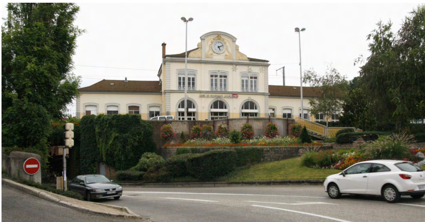
Gare SNCF et passage de la RD522
