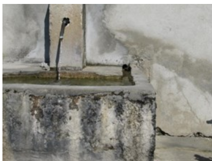
Bassin, rue Lamartine
