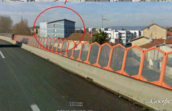
Des bâtiments du quartier du Champfleuri très proches de l'infrastructure autoroutière
