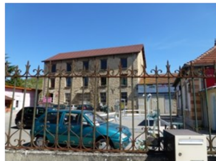
Ancienne minoterie électrique
