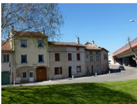
Vue depuis la rue Pasteur depuis le quai de la Bourbre
