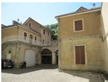
21/ Rue Pontcottiier : n°34 : ancienne brasserie (labélisée Patrimoine de l'Isère)
