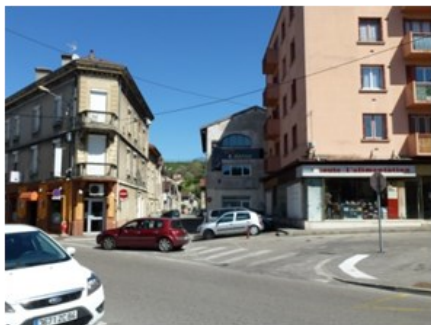
Rupture par les nouvelles constructions
