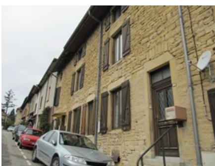
8/ La Grive : Les cités ouvrières rue des Silos et ch. des marais, lavoir, et le bâtiment ancien le long de la rue Nationale.
