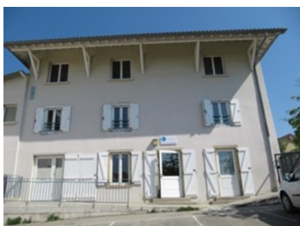
Réhabilitation d'un bâtiment ancien
