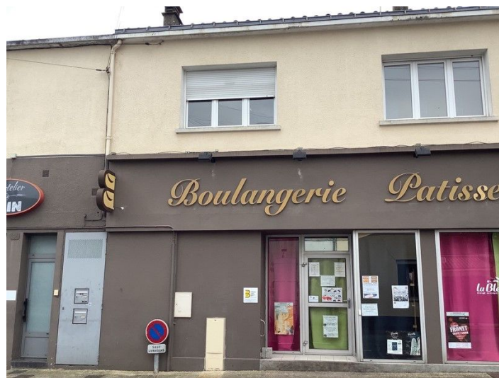
Enseigne dépassant sur l'entrée de l'immeuble limitrophe
